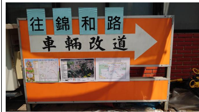
照片 1-改道牌面(一)
